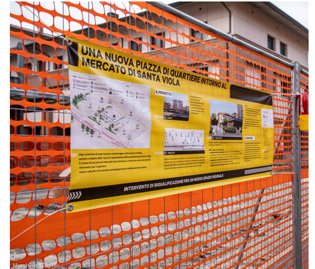
cartellonistica di cantiere FIU in Santa Viola
